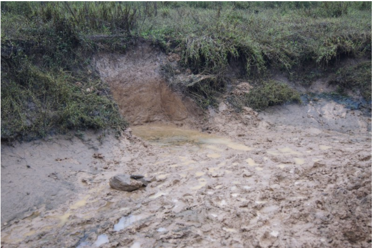
Obr. 8. Profil v erozním korytě v koncentraci 2.
