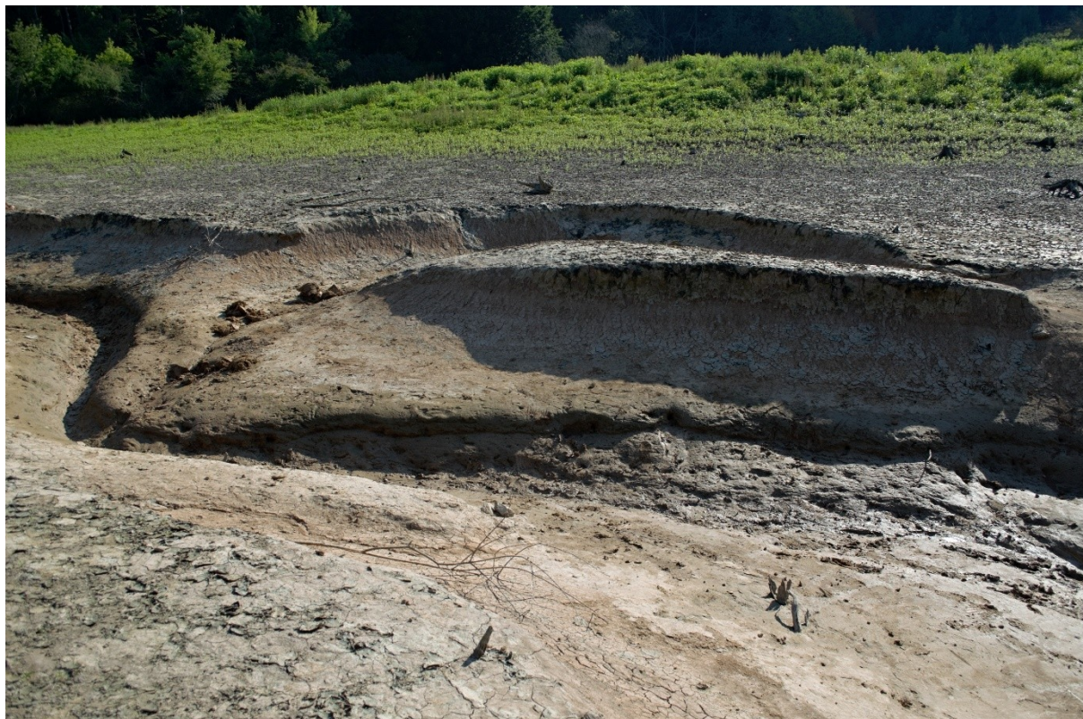
Obr. 4: Pohled na východní erozní koryto v průběhu čištění.
